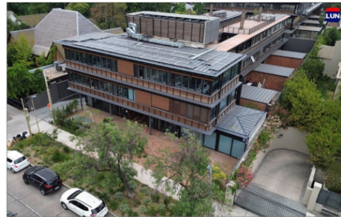
El edificio se ubica en Burgos 416, Las Condes.
