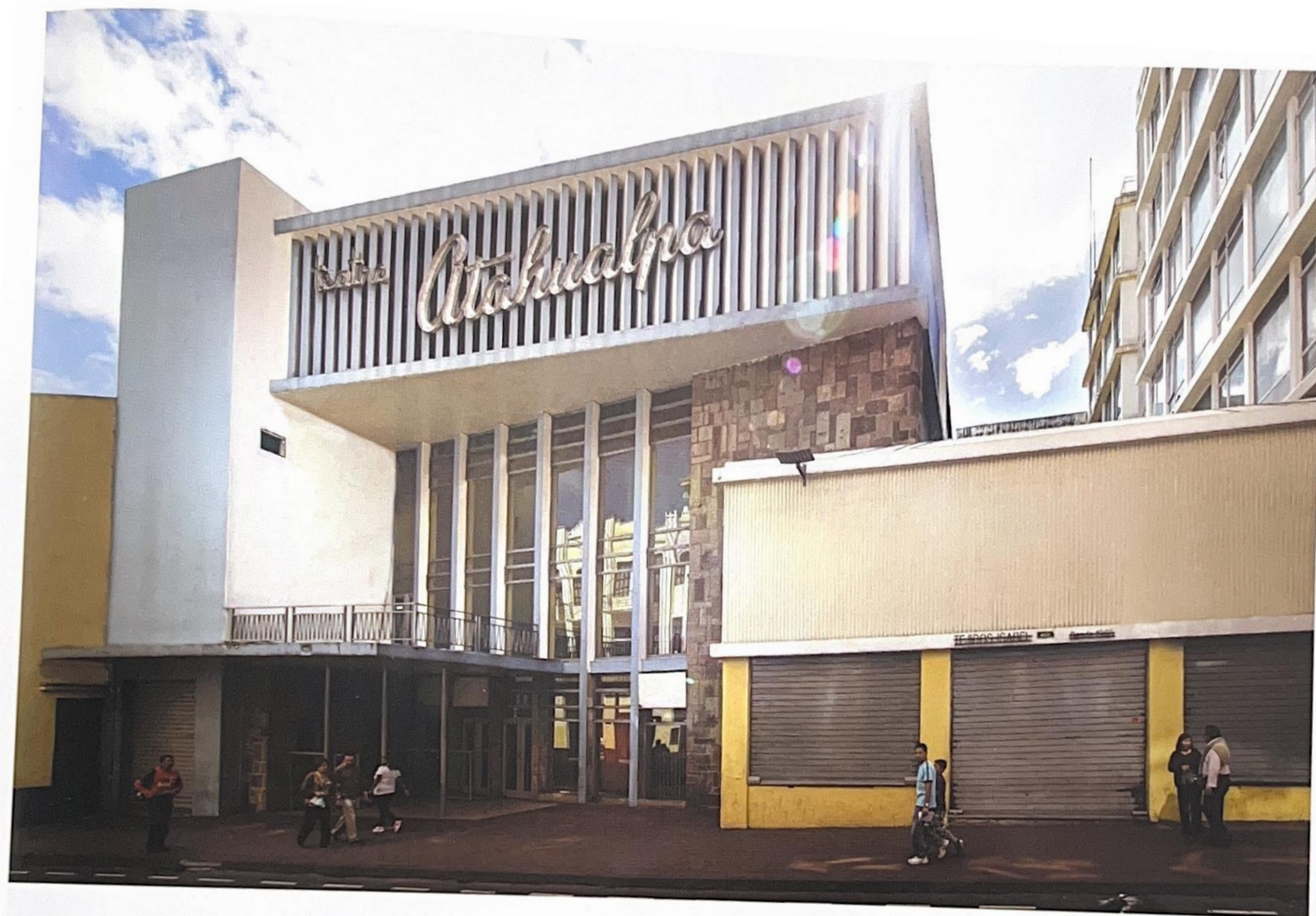
Conjunto edificio Bolívar y Teatro Atahualpa. Juego de volúmenes, de llenos y vacíos, de texturas lisas y trabajadas. Espacios de doble altura en el hall de ingreso.
